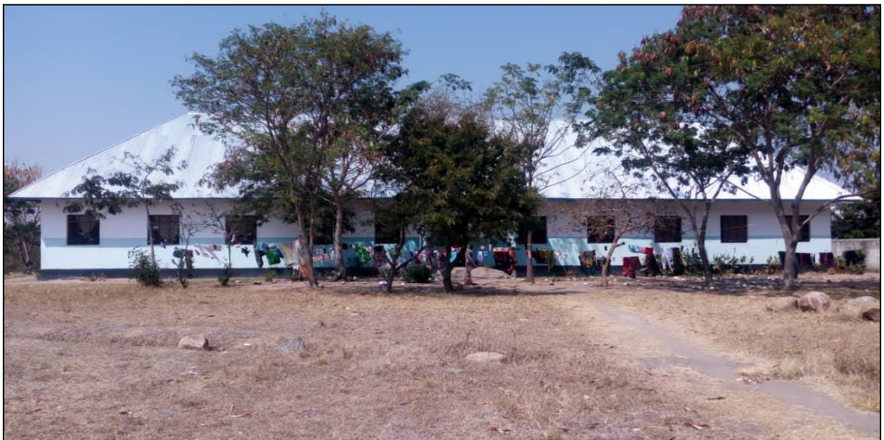
LUGEYE SEKONDARI: UJENZI WA BWENI 1 LA WASICHANA EP4R MIRADI 2017/2018
