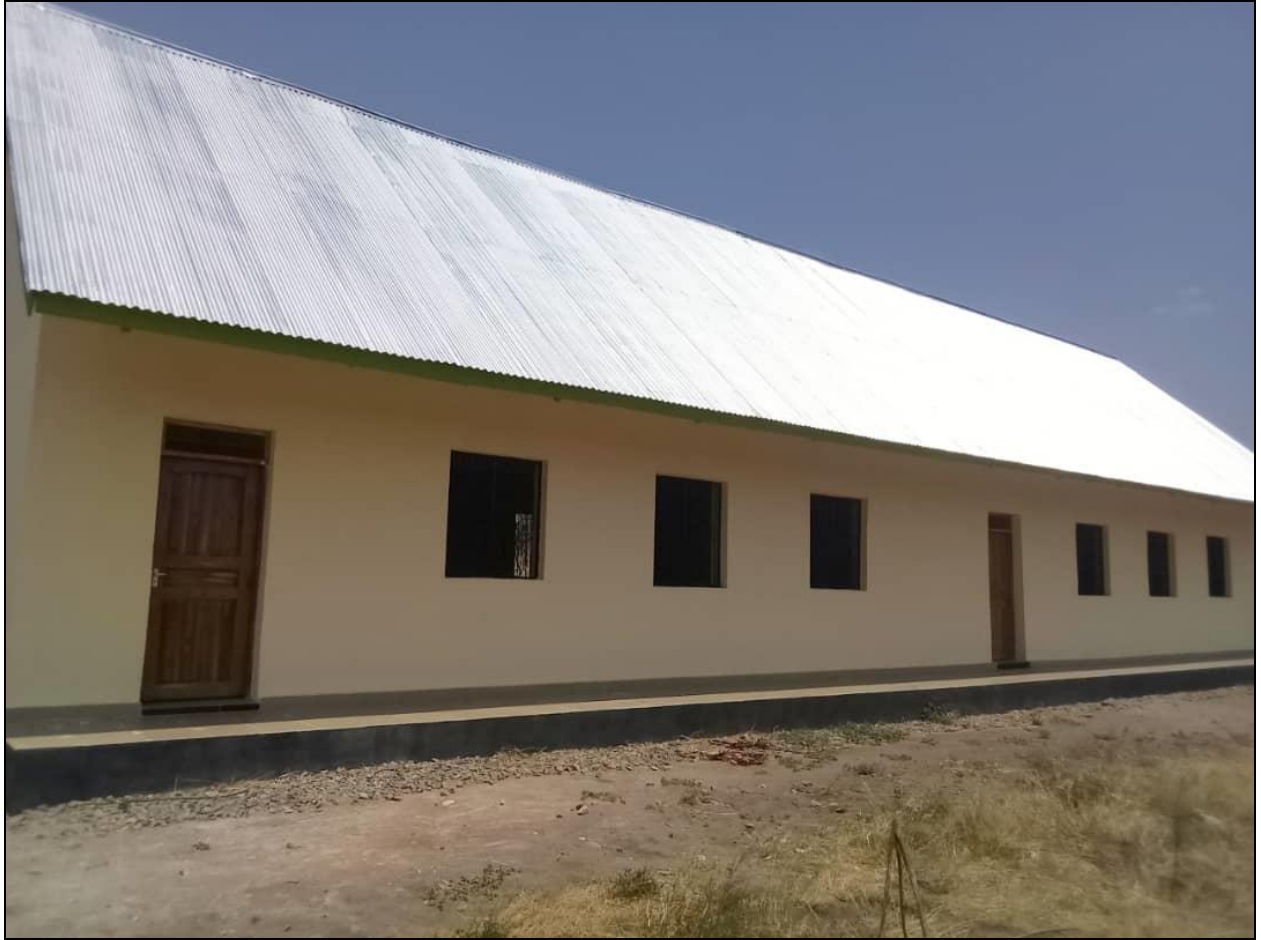
SUKUMA SEKONDARI: MRADI WA UJENZI WA MADARASA 2 UKAMILISHAJI MABOMA EP4R 2018/2019
