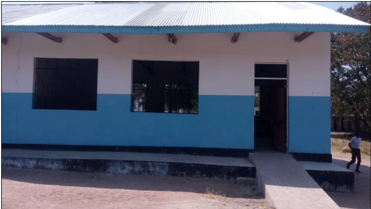
LUGEYE SEKONDARI: UJENZI WA CHUMBA 1 CHA DARASA EP4R MOTISHA 2018/2019
